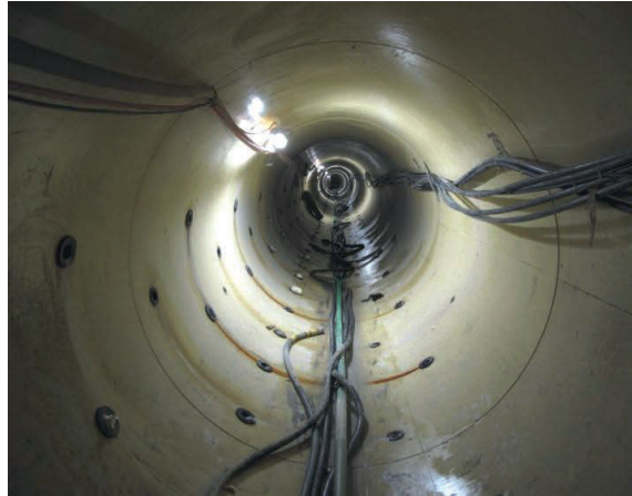
Rohrstrang mit Injektionsöffnungen
