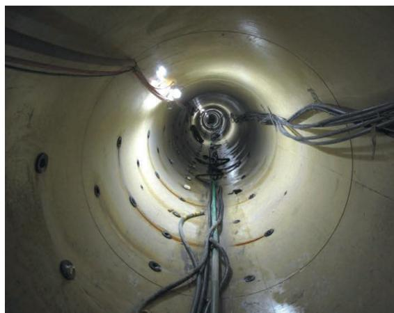
Ligne de tuyaux avec ouvertures d'injection
