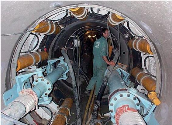
*Via di controllo punti intermedi di compressione (fonte: Herrenknecht)*
