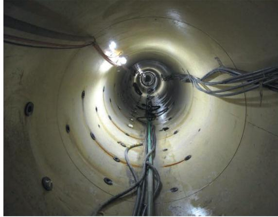
*Tube con aperture d'iniezione*
